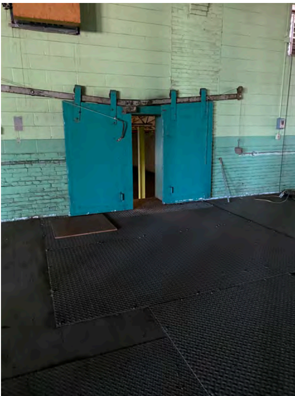
16 Fire door typical.JPEG
